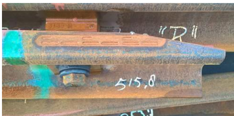
Figuur 11 Gefreesd materiaalmarkering VAE puntstuk
