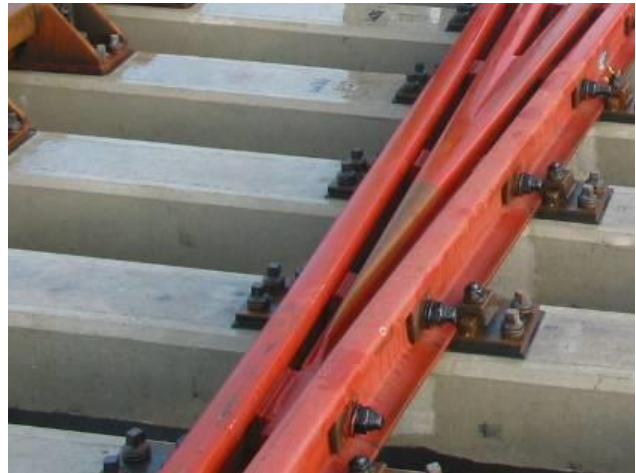
Figuur 17 Rugplaten met klembout en kraagbouten met veerringen op beton
