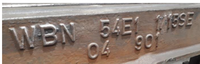
Figuur 8 Type aanduiding mangaan puntstuk
