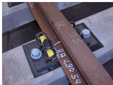
Figuur 23 Vulplaatje tussen spoorstaafvoet en bedding
