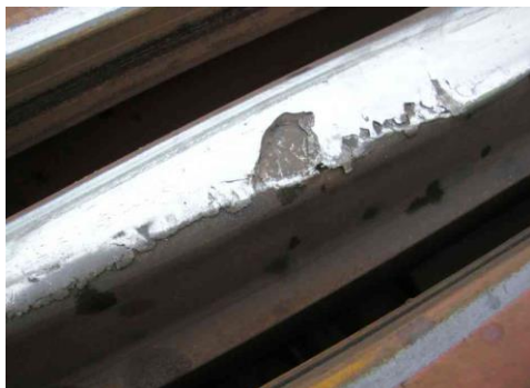
Figuur 25 Gevolgen niet preventief slijpen
