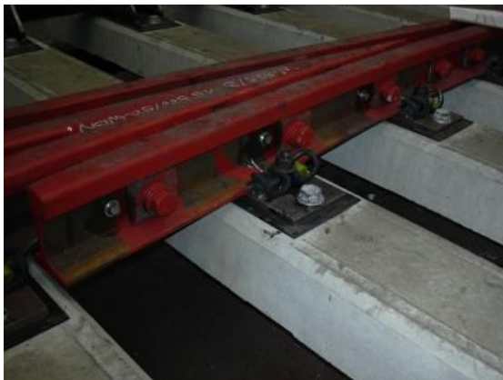
Figuur 18 Rugplaten met veerklem en doorsteekverbindingen op beton
