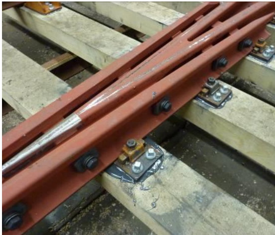
Figuur 16 Verlijmd rugplaten met klembout en kraagbouten op hout
