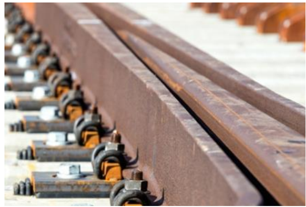
Figuur 19 Mangaan puntstuk met veerklem, railpad en doorsteekverbinding op beton (NG2.0)
