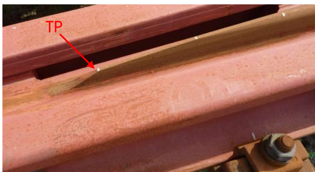
Figuur 20 Theoretisch punt (TP) puntstuk
